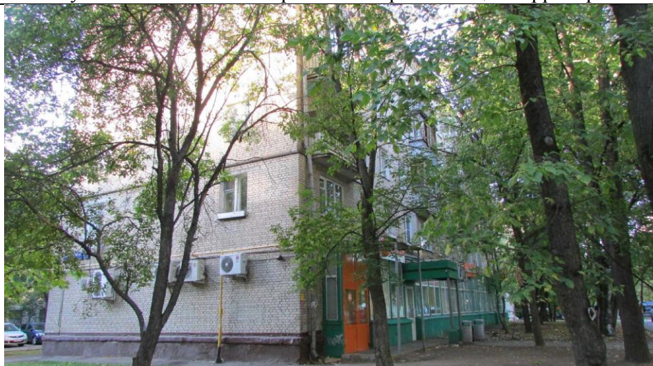
Рисунок 6.20 Наземная парковка на прилегающей территории
