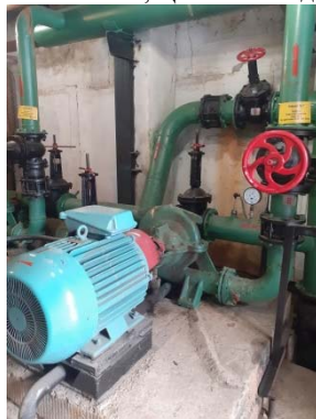
Насос №1 Д320-50 с электродвигателем АИР 75 кВт, 1450 об-мин, инв. №000142866, ЦТП №6 ГТМ
