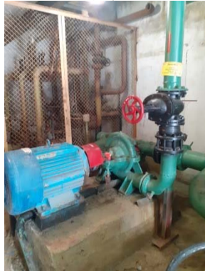
Насос №3 Д320-50 с электродвигателем АИР 75 КВт, 1450 об-мин, инв. №000142866, ЦТП №1 ГТМ
