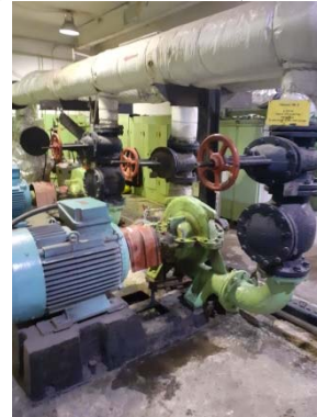
Насос №6 Д320-50 с электродвигателем АИР 75 КВт, 1450 об-мин, инв. №000142866, ЦТП № Лисьегорский ГТМ
