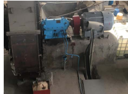
Насос №1 Д320-50 с электродвигателем АИР 75 кВт, 1450 об-мин, инв. №000142866, ЦТП №1 ГТМ
