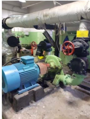
Насос №6 Д320-50 с электродвигателем АИР 75 КВт, 1450 об-мин, инв. №000142866, ЦТП № Лисьегорский ГТМ
