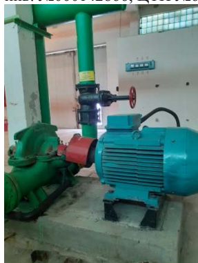
Насос №1 Д320-50 с электродвигателем АИР 75 кВт, 1450 об-мин, инв. №000142866, ЦТП №6 ГТМ
