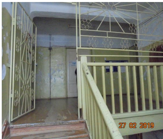
Лестница на второй этаж.
