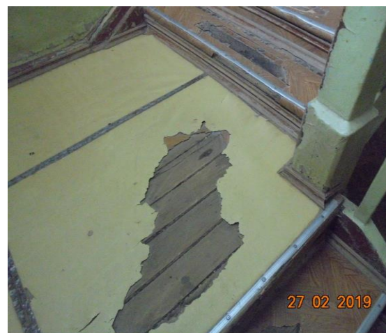
Лестница на второй этаж.
