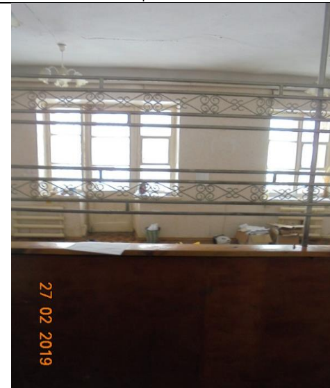
Помещения 2-го этажа.
