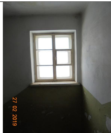
Лестница на второй этаж.
