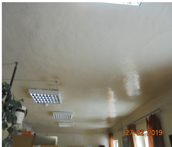
Помещения 1-го этажа.
