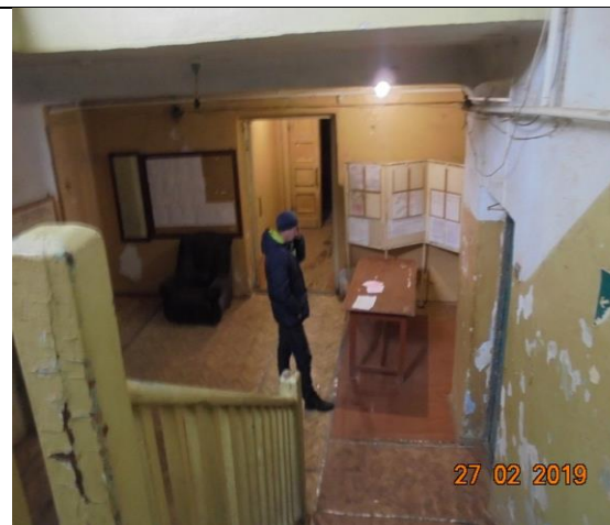
Лестница на второй этаж.
