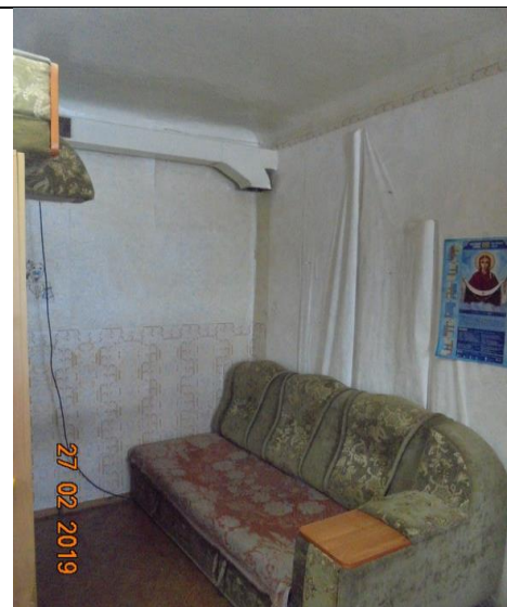
Помещения 1-го этажа.
