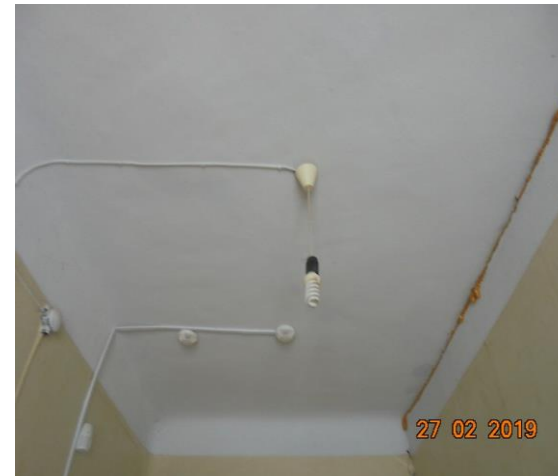
Помещения 1-го этажа.
