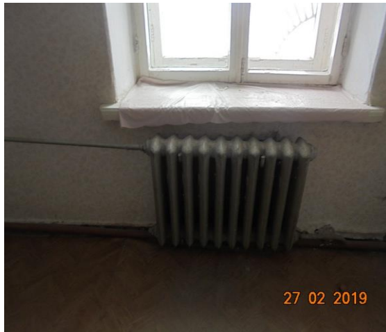
Помещения 1-го этажа.
