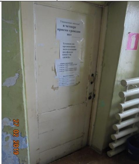
Помещения 2-го этажа.
