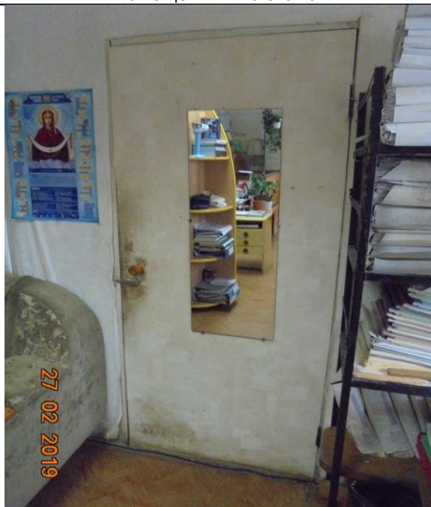
Помещения 1-го этажа.
