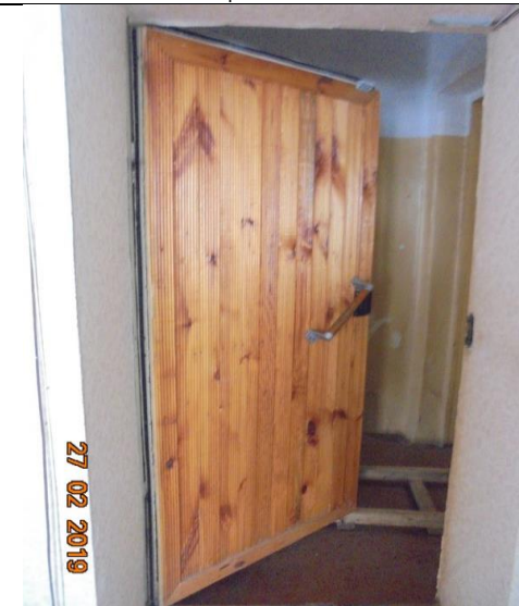
Помещения 1-го этажа.
