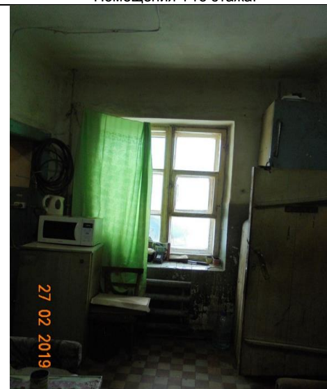
Помещения 1-го этажа.
