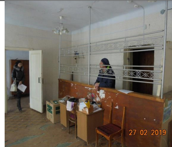
Помещения 2-го этажа.
