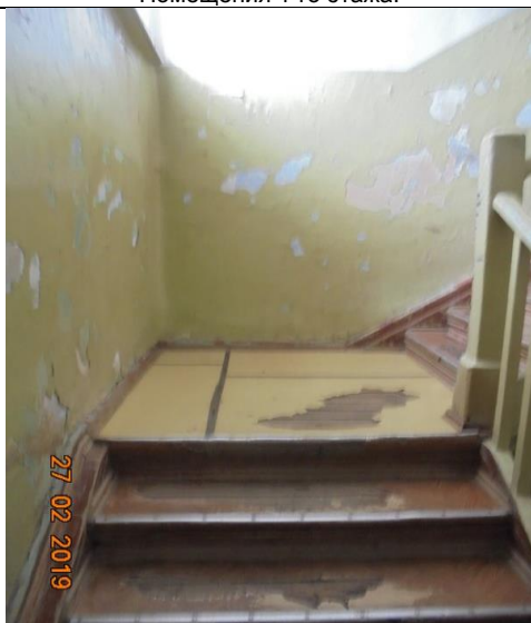
Лестница на второй этаж.
