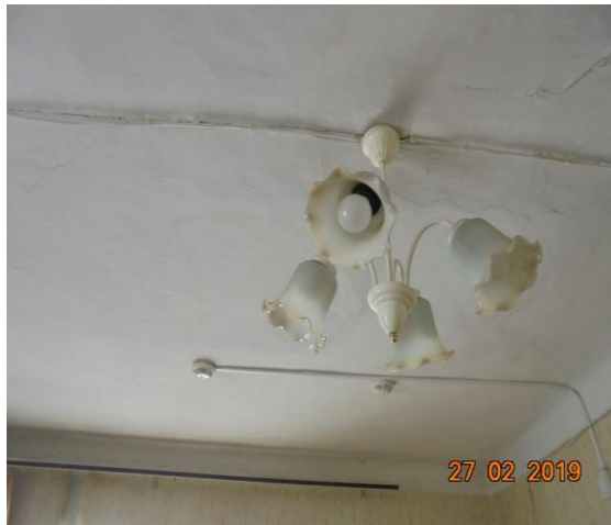
Помещения 2-го этажа.
